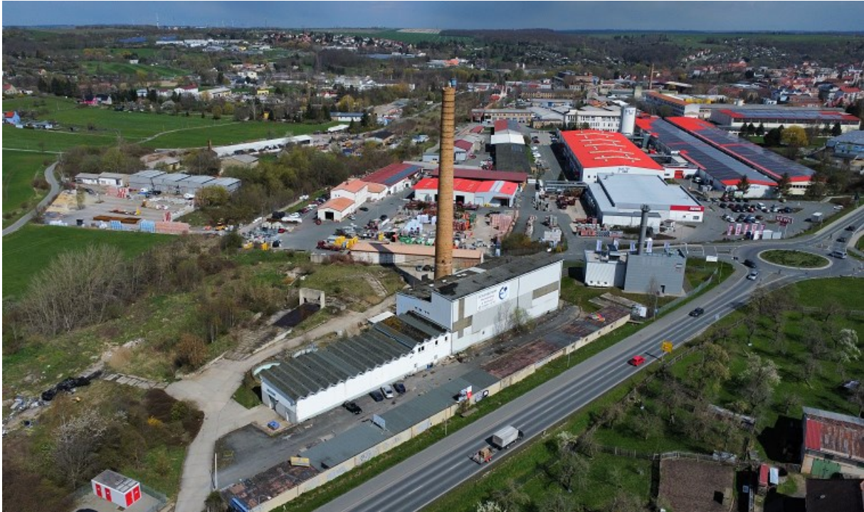
Blick auf das Gelände des ehemaligen Heizhauses in der Jenaer Straße in Eisenberg - geplanter Standort für den Verwaltungsneubau des Landratsamtes. (Foto: LRA/Maria Stollberg)
