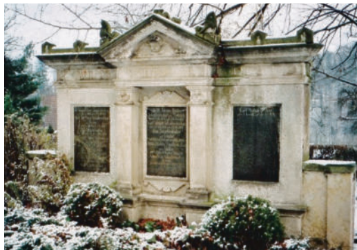
Die Schieferdeckersche Grabanlage auf dem Hl. Kreuzfriedhof in Stadtroda. Deren Erhalt kommt der Erlös der Strom-Broschüre zugute.
