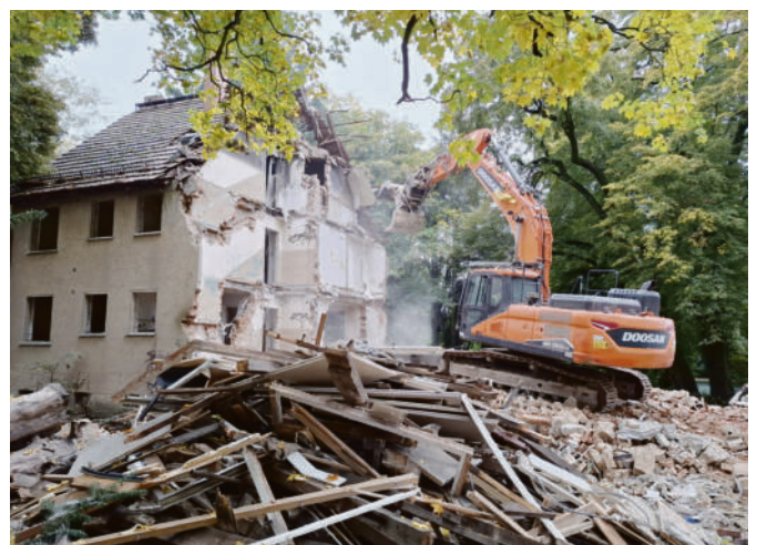
Im südwestlichen Teil des Hummelshainer Schlossparks wurde kürzlich die Ruine eines alten Wohnblocks abgerissen – erneut als Ausgleichsmaßnahme für ein Bauprojekt im Landkreis. (Foto: Hohberg)
