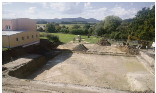
Bereit für die Zeitkapsel: das Baufeld für die neue Grundschule in Orlamünde. (Foto: Landratsamt)
