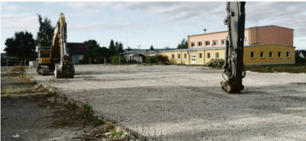
Blick auf die Baustellen für die neuen Grundschulen in Stadtroda (oben: Schalung der Wände im 2. Obergeschoss) und Orlamünde (Bild Mitte: komplett mit Betonrecycling aufgefüllter Bereich des ehemaligen Schulgebäudes) sowie für die neue Schulturnhalle in Stiebritz (unteres Bild). Alle Aufnahmen aus dem August 2025. (Fotos: Landratsamt)
