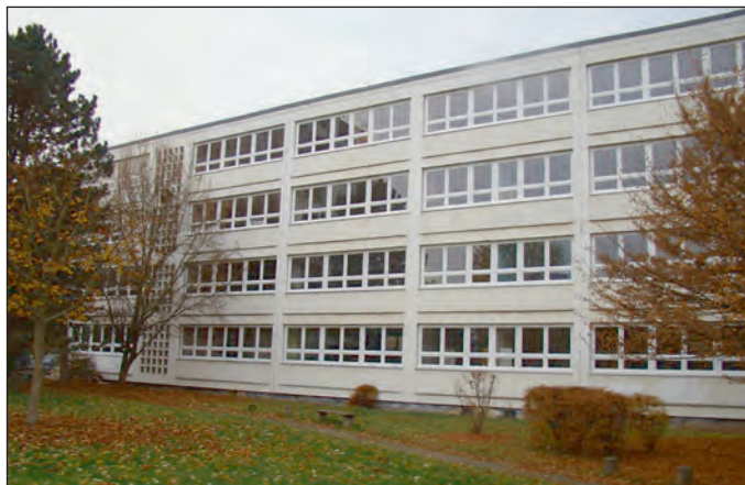
Holzlandgymnasium Hermsdorf - Erneuerung der Fenster zur Straßenseite aus Mitteln des Konjunkturpaketes II (100.000 EUR)
