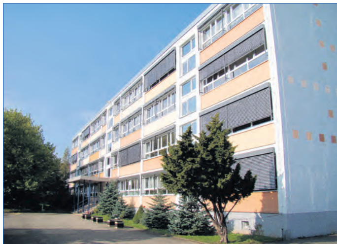
Regelschule „Karl Christian Friedrich Krause“ in Eisenberg Sanierung der Fenster mit Sonnenschutzanlagen und der Außentüren durch Mittel aus dem Konjunkturpaket II. Bausumme: 400.000 EUR
