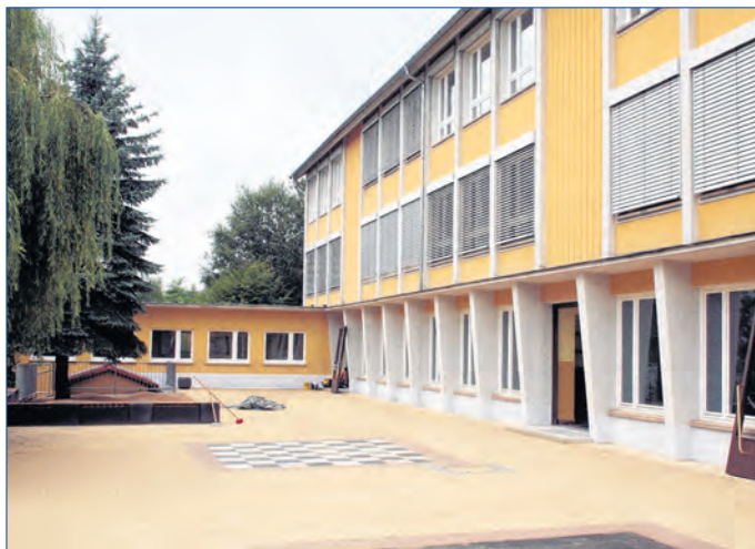
Grundschule „Hügelland“ Tröbnitz Sanierung der Fenster mit Sonnenschutzanlagen und der Außentüren, Trockenlegung aus Mitteln des Konjunkturpaketes II. Bausumme: 437.000 EUR
