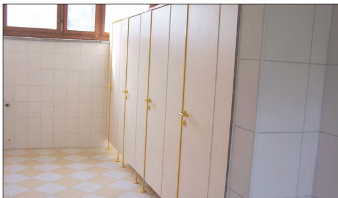
Neue sanitäre Anlagen wurden im Förderzentrum Ottendorf für 32.000 Euro eingebaut.
