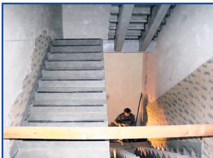
In der neuen Grundschule Bad Klosterlausnitz wird gegenwärtig das Treppenhaus erneuert. Ein Mitarbeiter der Fa. Enke Hochbau GmbH aus Nimritz setzt gerade eine Trittstufe Foto: LRA
